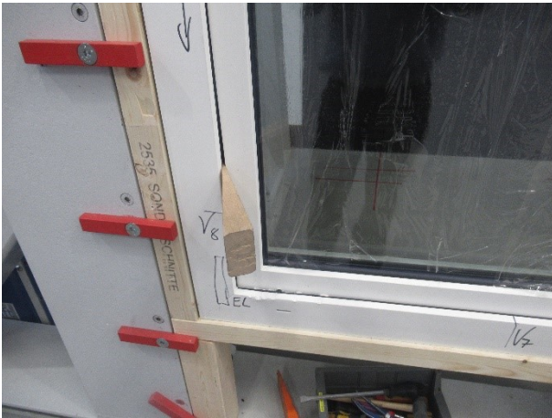
Bild 13 Schäden aus manueller Prüfung "Eck-lager"
