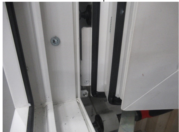
Bild 6 Ecklager mit Befestigungsschraube des Probekörpers
