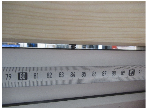
Bild 8 Montagefuge mit Schraube ohne druckfeste Hinterfüterung
